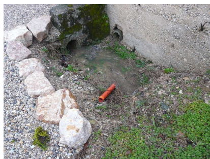
Débordement au niveau de la voirie, les réseaux et fossés n'étant pas en charge
